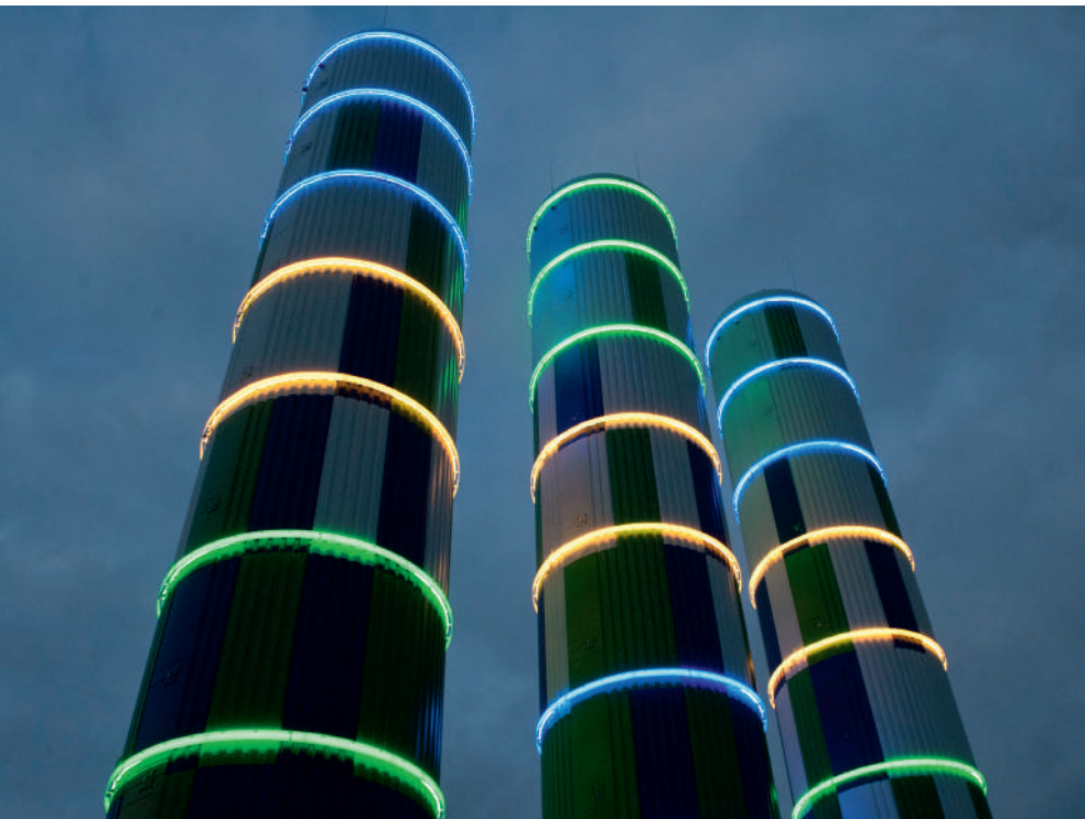
Die Technik der Wärmespeicher dient dazu, die Effizienz unseres Kraftwerks zu steigern.
