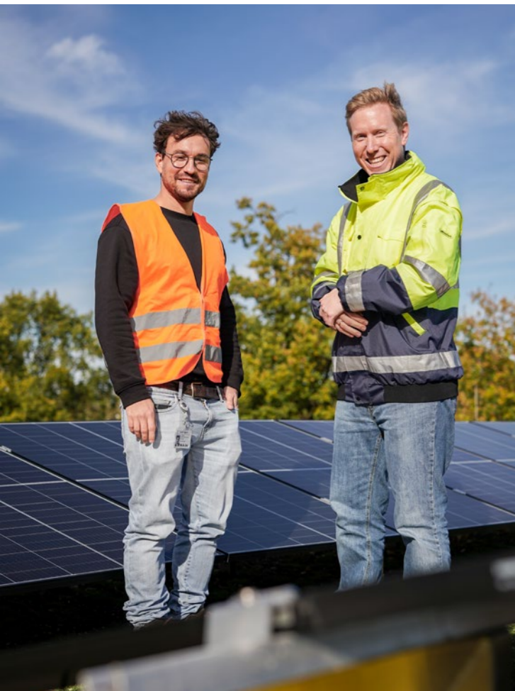
Fachkundiges Personal plant, installiert und wartet die Photovoltaik-Anlagen Hamburgs.
