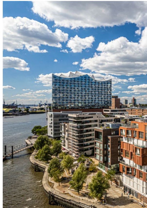
Auch die Elbphilharmonie versorgen wir über unser städtisches Fernwärmenetz mit Wärme zum Heizen und zur Warmwasserbereitung.
