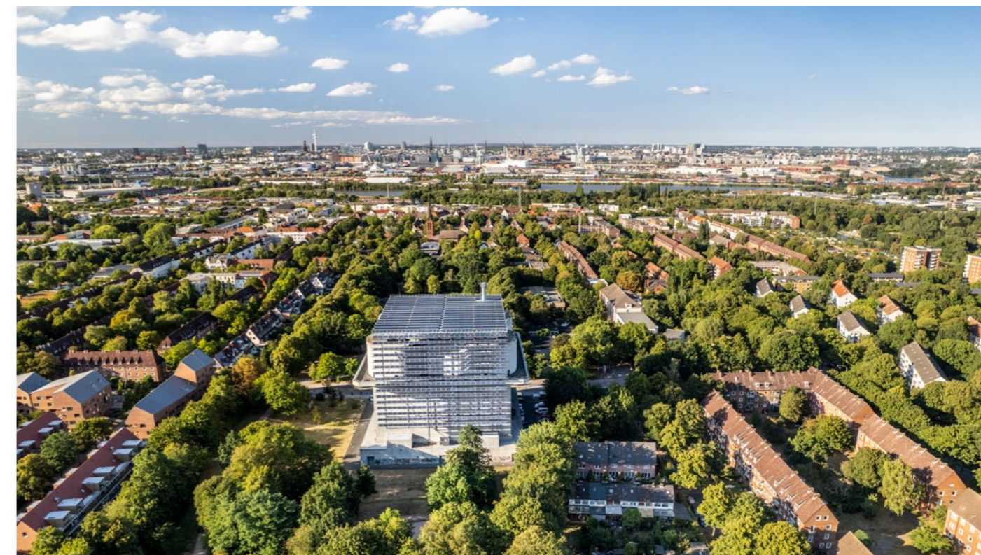
Der Energiebunker erzeugt dank eines modularen Erzeugungssystems lokal Wärme und Ökostrom für das gesamte Reihertiegviertel in Wilhelmsburg.
