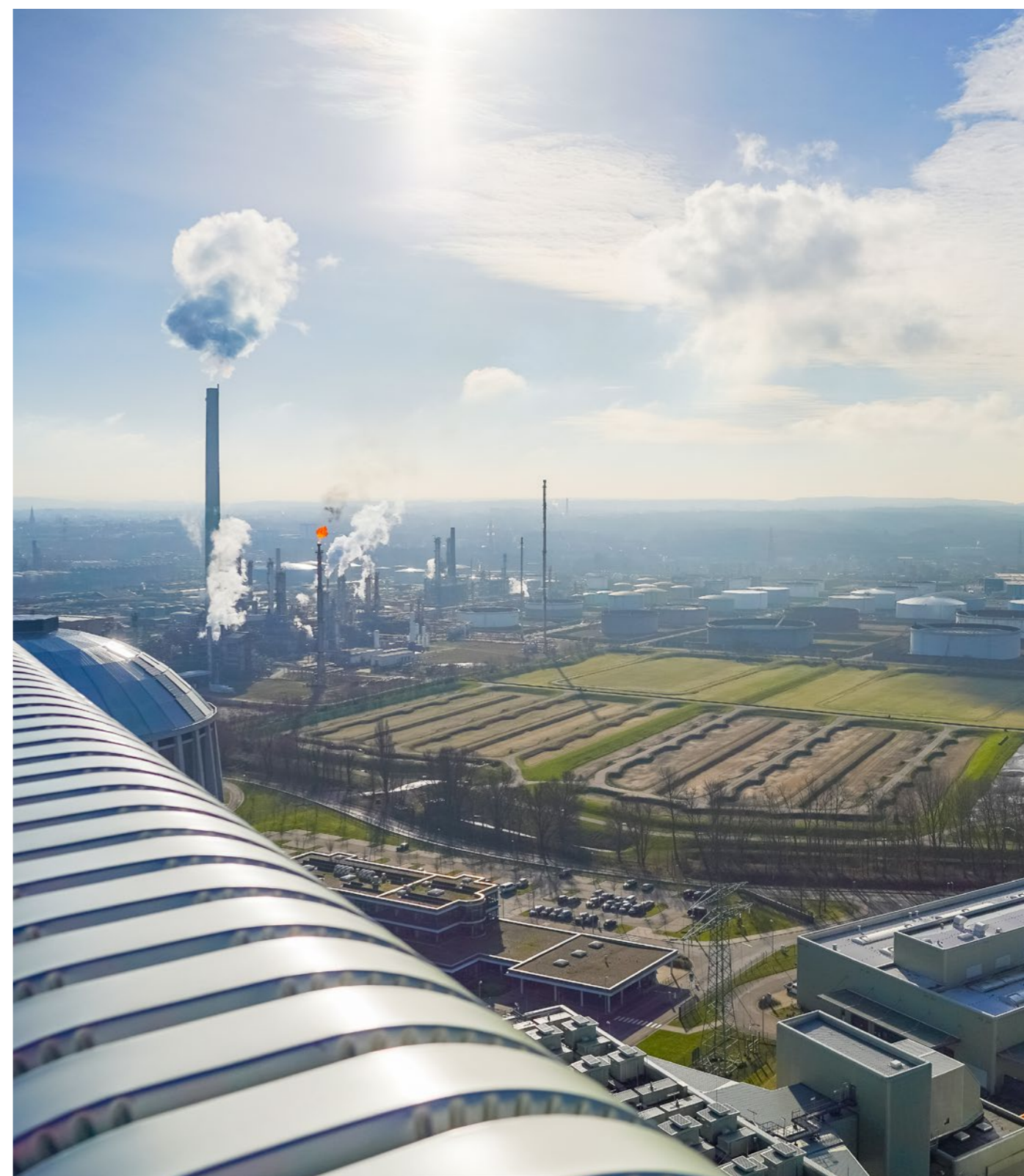
Im industriell geprägten Stadtteil Moorburg entsteht Hamburgs erster Elektrolyseur zur Herstellung von grünem Wasserstoff.
