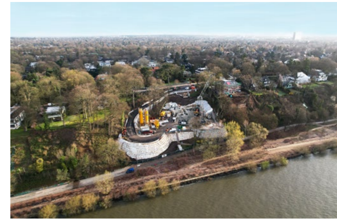
Am Zielschacht im Hindenburgpark trifft die Südleitung als neue Fernwärmetrasse nach Unterquerung der Elbe wieder auf Land.
