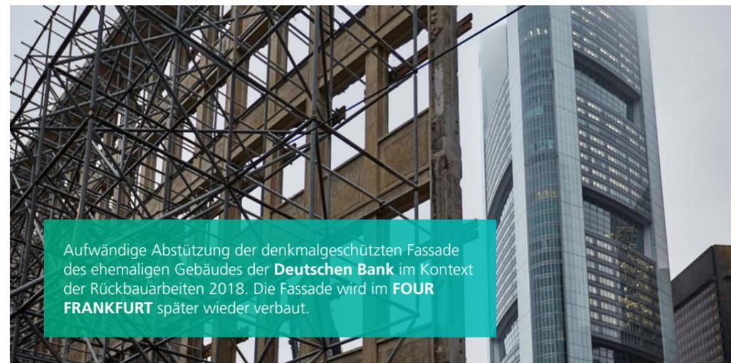
Aufwändige Abstützung der denkmalgeschützten Fassade des ehemaligen Gebäudes der **Deutschen Bank** im Kontext der Rückbauarbeiten 2018. Die Fassade wird im **FOUR FRANKFURT** später wieder verbaut.
