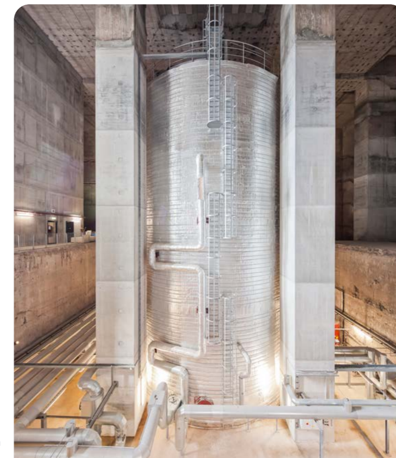
Speicher im Energiebunker.
