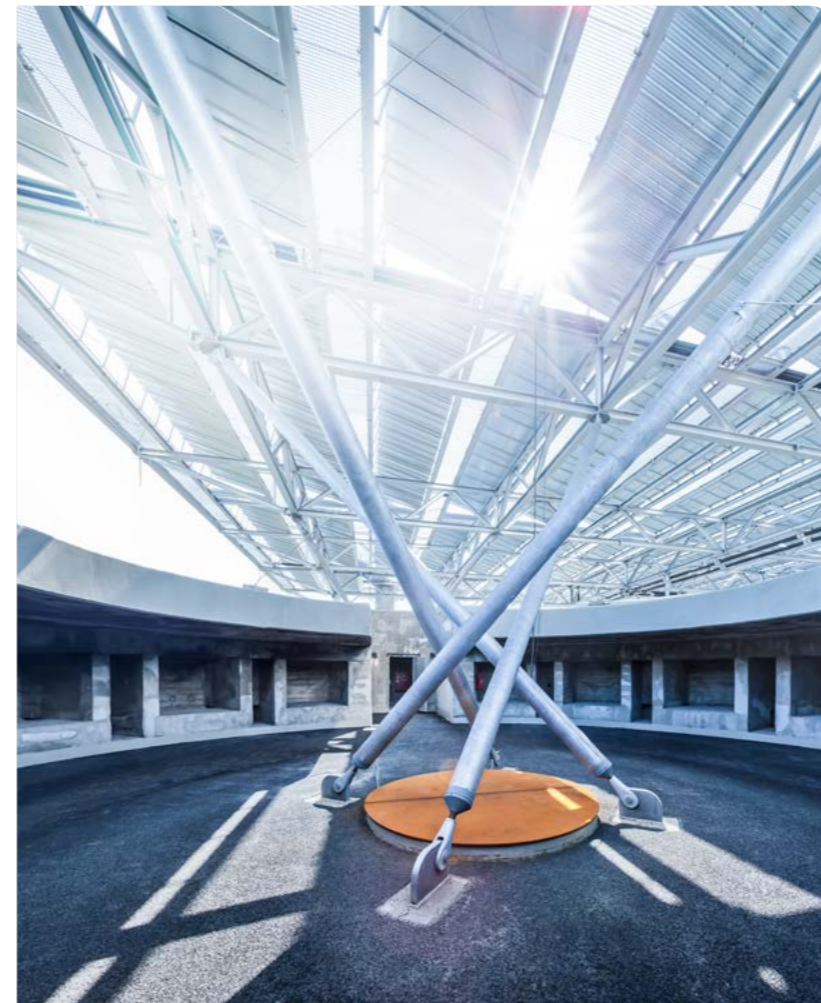
Photovoltaikanlage von unten betrachtet.
