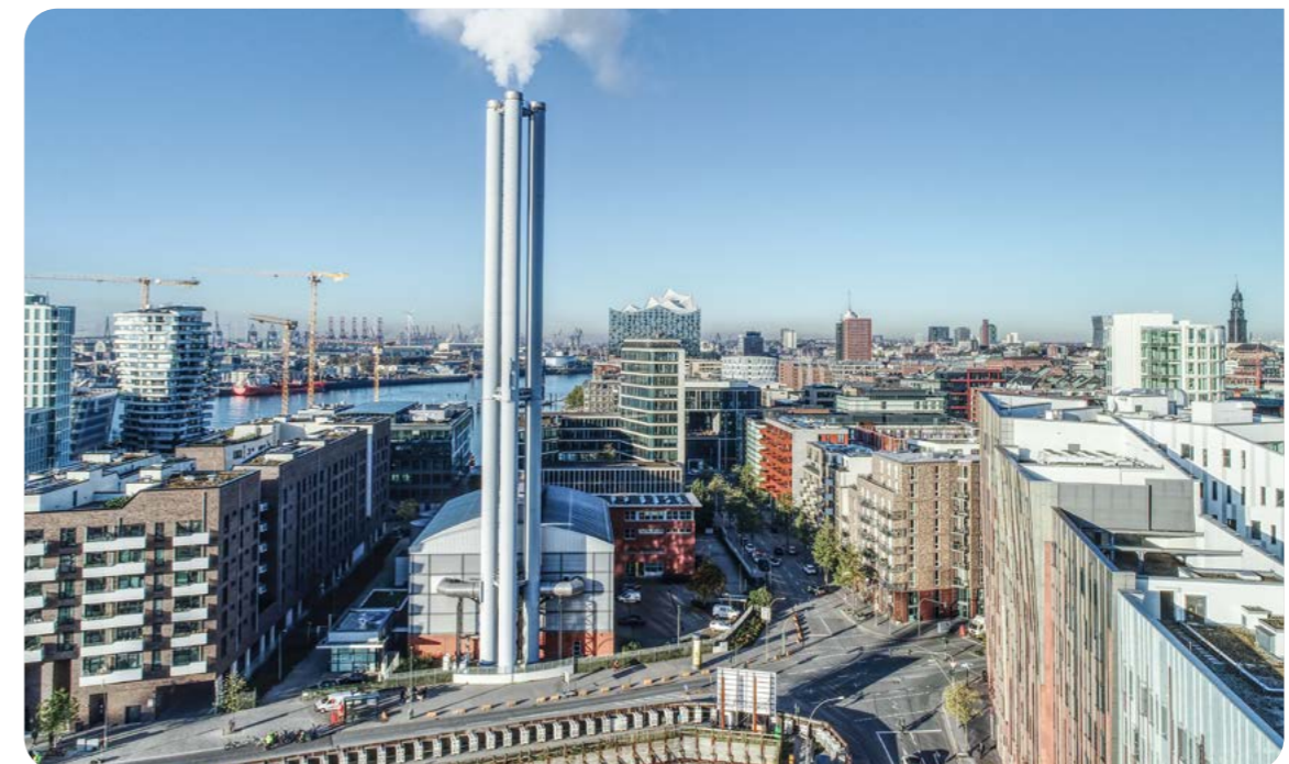
Im Heizwerk Hafencity wird durch den Einsatz von Erdgas die Umwelt geschont.
