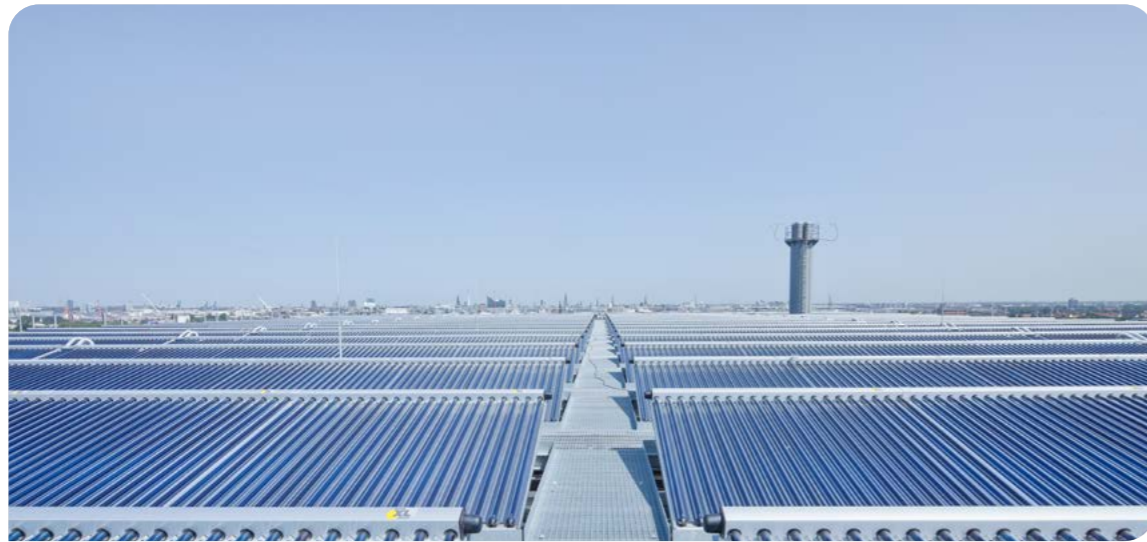
Vakuumröhrenkollektoren auf dem Dach des Energiebunkers im Stadtteil Wilhelmsburg.
